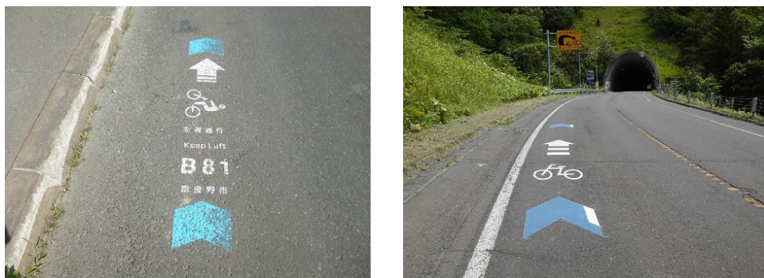
図 18 走行環境整備状況（路面表示）
